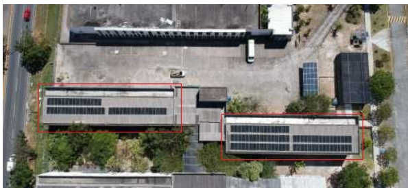
Figura 1: Vista superior dos conjuntos de painéis fotovoltaicos do IFCE Maracanaú.
