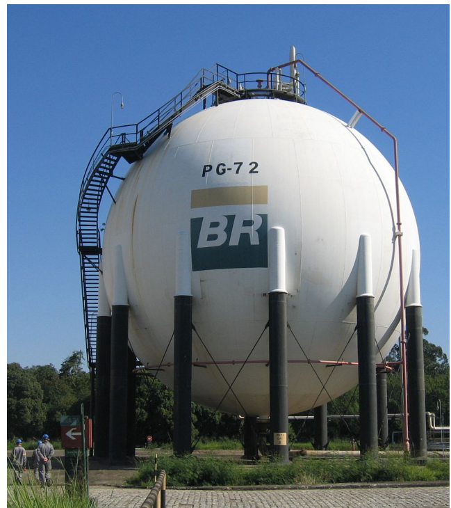
Figura 1: Tanque esférico de armazenamento de derivados de petróleo [1].
